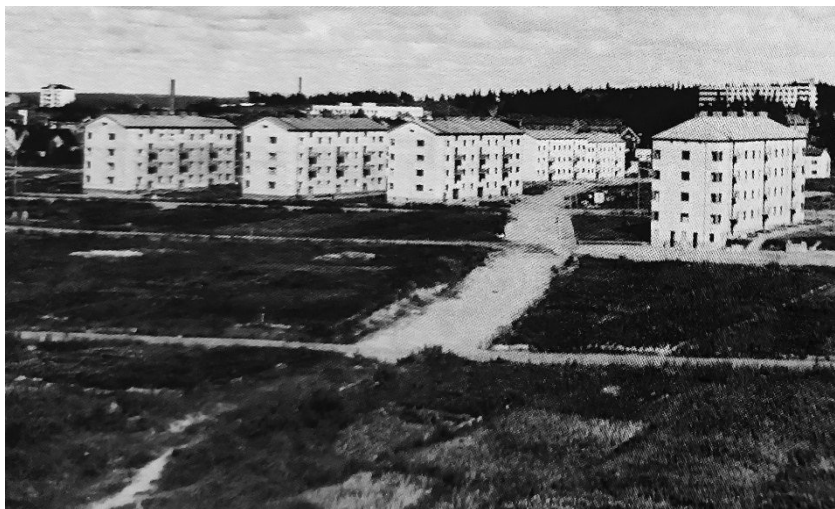
Näkymä Liisanpuistosta Kauppiin 1940-luvulla, etummainen polku on tuleva Teiskontie, Petsamonkatu on jo levennetty ja Ilmarinkadun taloja rakennettu. Kuva J. Kangas.
