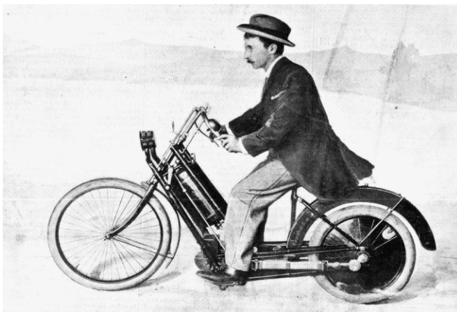
Hildebrand & Wolfmüllerin voima moottorilta takapyörälle siirtyy pitkällä tangoilla suoraan kampiakselilta. Tankojen palautuminen varmennettiin kumihihnoilla. Ajajan vasemman jalan takana vaakasuorassa näkyy musta työntötanko ja sen alapuolelle vaalea kuminen työntötangon palautushihna.
